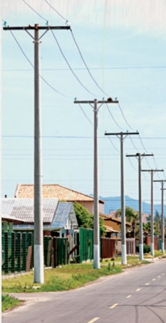
Obra nova (alimentadores), concluída no Litoral Norte. Foto de 23/09/14, em Atlântida
